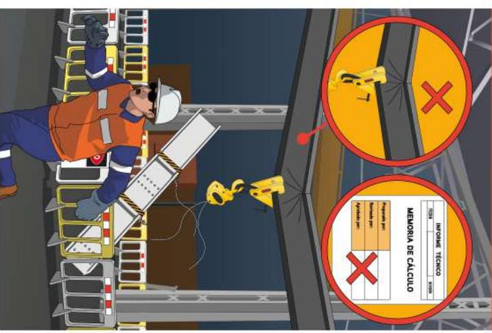
VIGA COLAPSA ANTE PESO DE LA CARGA DURANTE IZAJE
